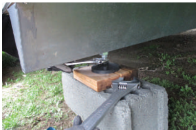
Einstellung der Spindel mit Rollgabelschlüssel abschließen.
