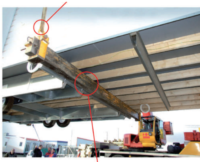
Barra de elevación perpendicular a los listones y cercana a la parte central metálica
