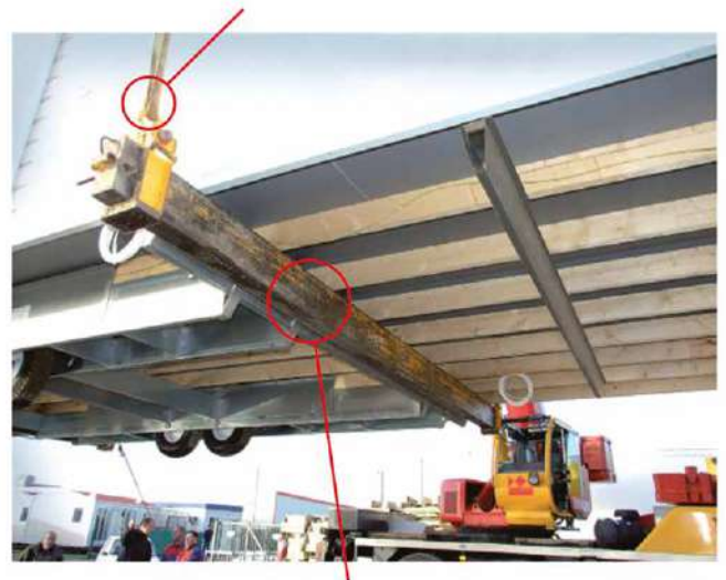
Hubstange senkrecht zu den Auflagebalken und in der Nähe der mittleren Metallpartie.
