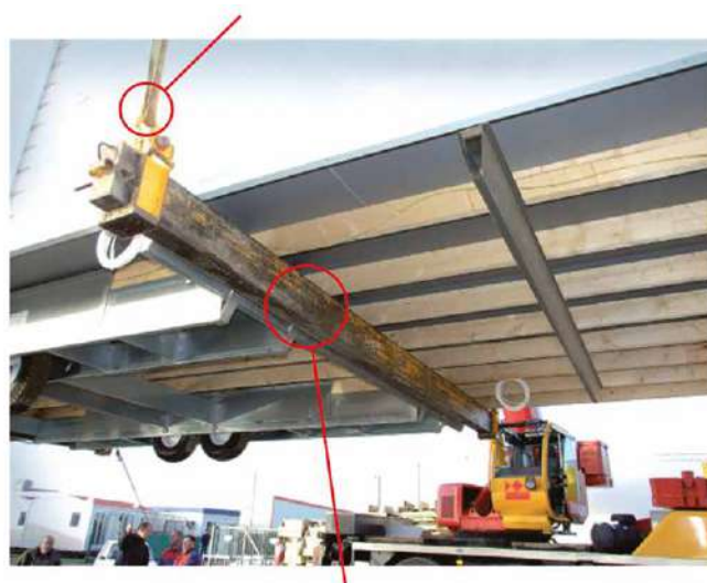
Barre de levage perpendiculaire aux lambourdes et proche de la partie centrale métallique.
