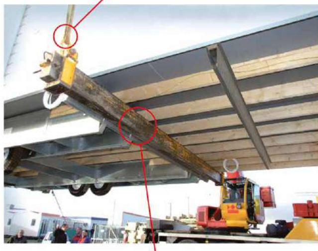
Hefbalk haaks op de steunbalken en dicht bij het metalen middengedeelte.
