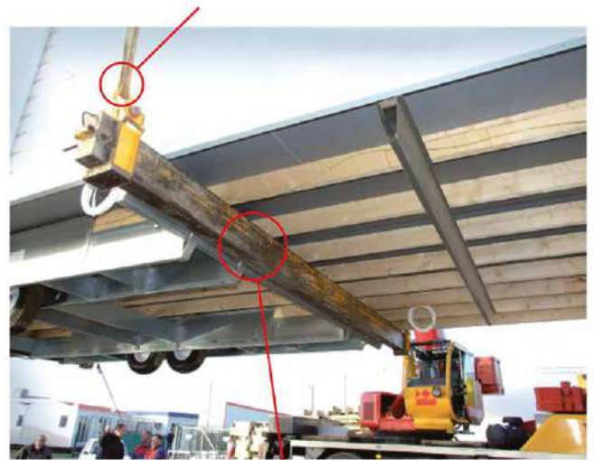
Hubstange senkrecht zu den Auflagebalken und in der Nähe der mittleren Metallpartie.
