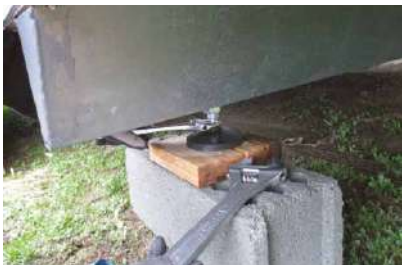
Einstellung der Spindel mit Rollgabelschlüssel abschließen.
