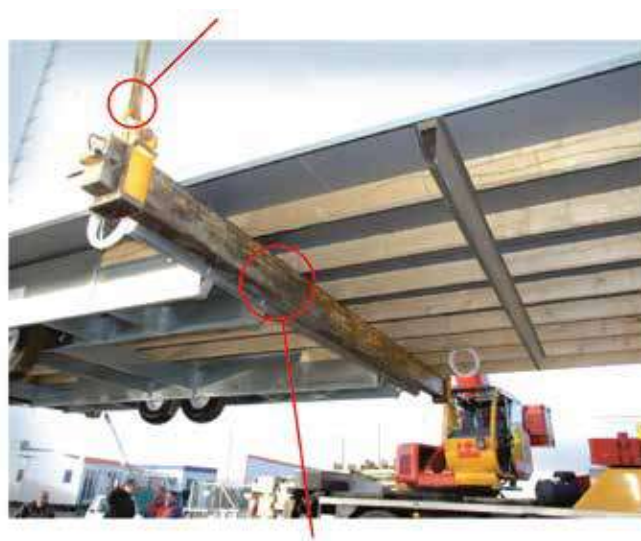
Barre de levage perpendiculaire aux lambourdes et proche de la partie centrale métallique.
