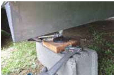
Einstellung der Spindel mit Rollgabelschlüssel abschließen.
