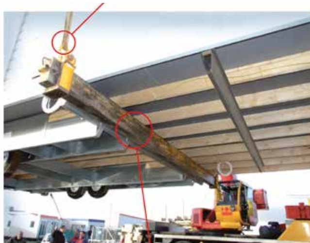
Barra de elevación perpendicular a los listones y cercana a la parte central metálica
