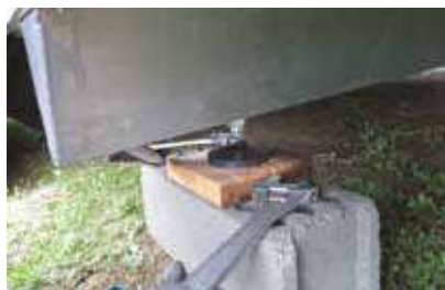
Einstellung der Spindel mit Rollgabelschlüssel abschließen.
