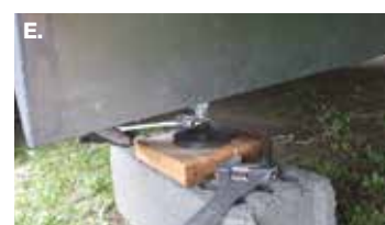
Terminar la regulación con los gatos utilizando una llave inglesa
