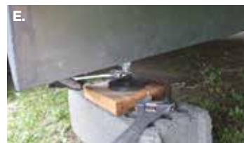
Completare la regolazione con i martinetti, usando una chiave inglese
