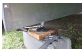
Finaliser le réglage grâce aux vérins à l'aide d'une clé à molette.
