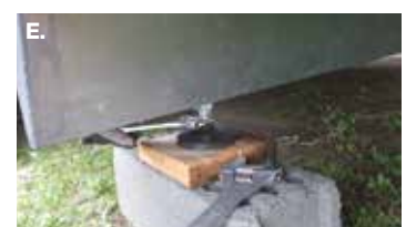
Einstellung der Spindel mit Rollgabelschlüssel abschließen.
