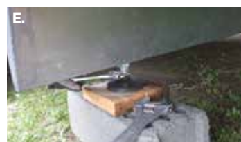
Voltooi de instellingen met behulp van de vijzels en een bahco.
