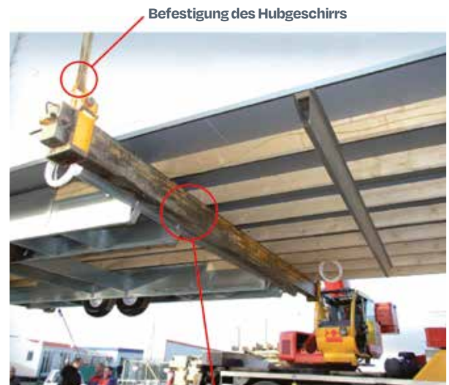
Hubstange senkrecht zu den Auflagebalken und in der Nähe der mittleren Metallpartie.
