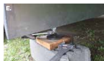
Completare la regolazione con i martinetti, usando una chiave inglese
