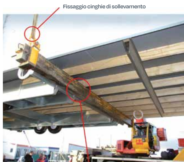
Barra di sollevamento perpendicolare alle armature di sostegno e vicina alla parte centrale metallica
