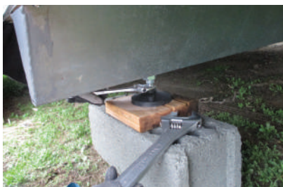
Einstellung der Spindel mit Rollgabelschlüssel abschließen.
