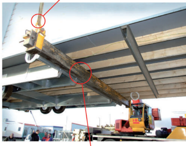
Hefbalk haaks op de steunbalken en dicht bij het metalen middendeel.
