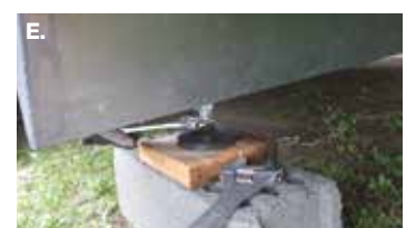
Einstellung der Spindel mit Rollgabelschlüssel abschließen.
