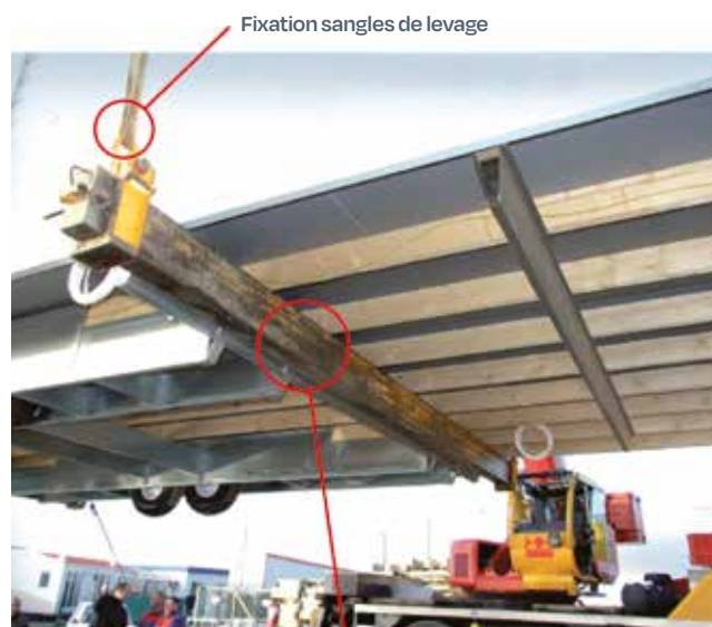
Fixation sangles de levage Barre de levage perpendiculaire aux lambourdes et proche de la partie centrale métallique.
