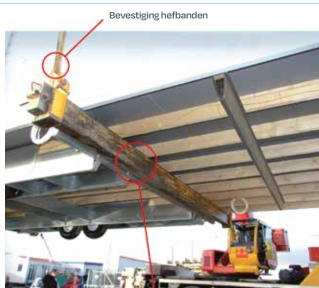
Hefbalk haaks op de steunbalken en dicht bij het metalen middengedeelte.
